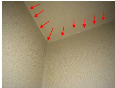
図 18—透明インドア光ファイバ 施工例
