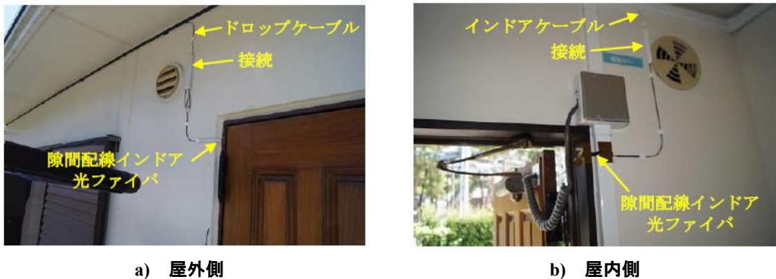
図 14－隙間配線インドア光ファイバ施工例
