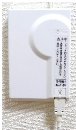
図 8—光ローゼット施工例
