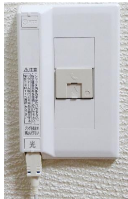
図 7—光アウトレット 一連タイプ施工例
