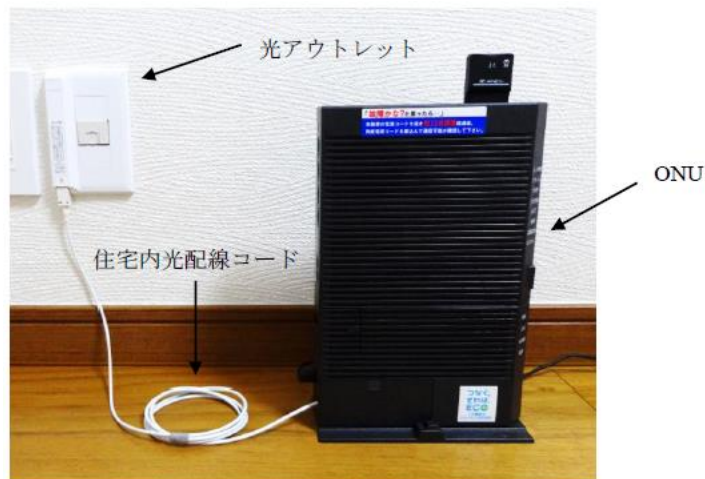
図 15ー光アウトレットを用いた屋内光配線施工例
