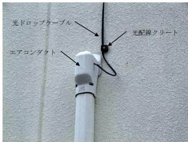
図 11－エアコンダクトを利用した光回線引込み施工例（住宅外壁部）
