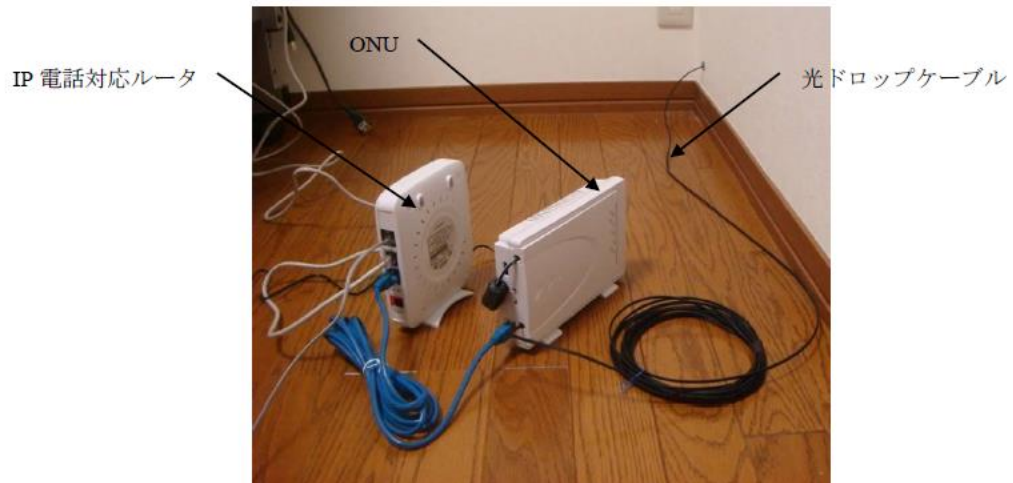
図 20－フリー配線の施工例
